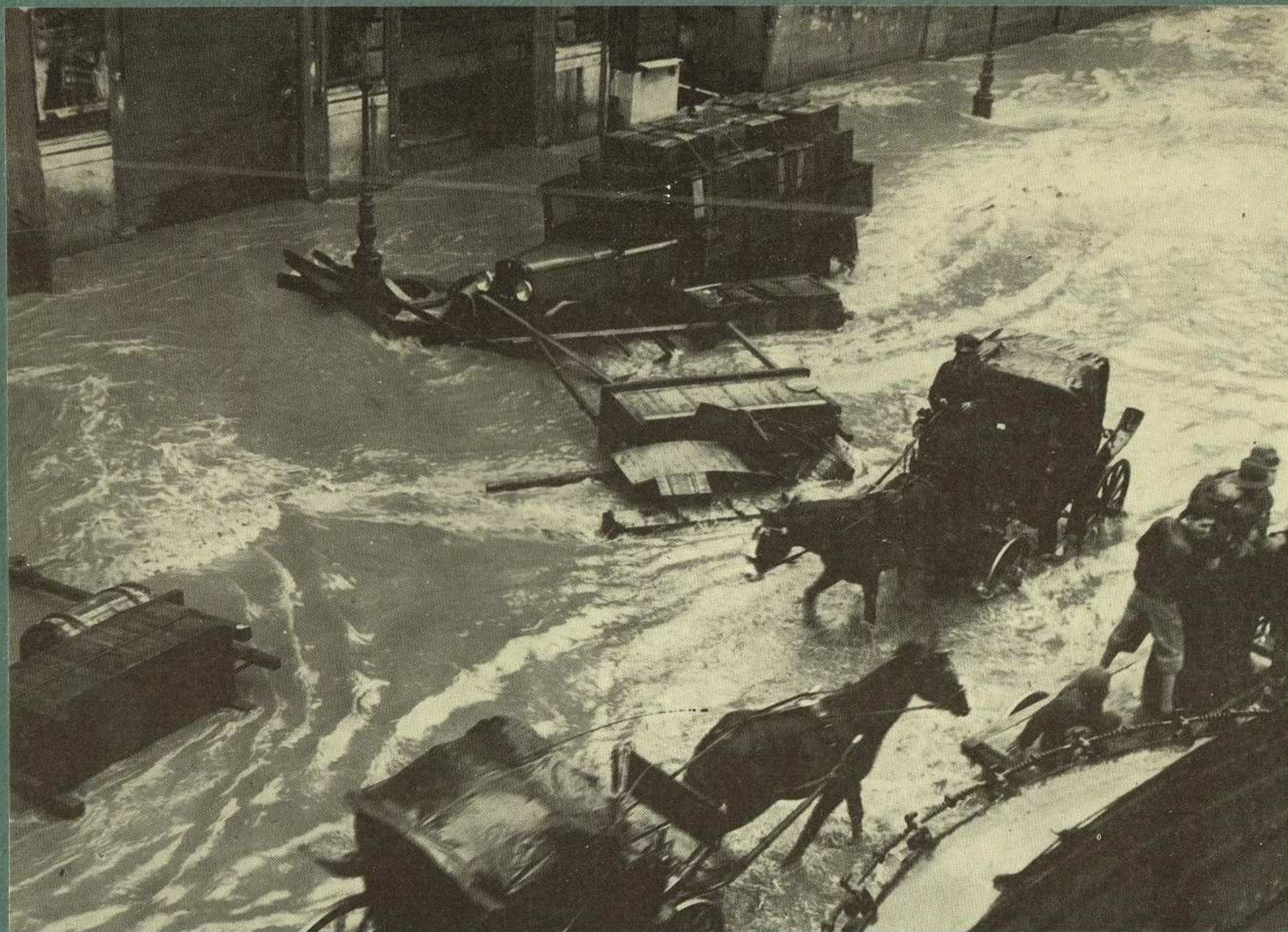
2 - Lo stesso tratto di Via Roma, di cui alla foto precedente. Qui successivamente l'acqua raggiunse l'altezza di 2 metri.
