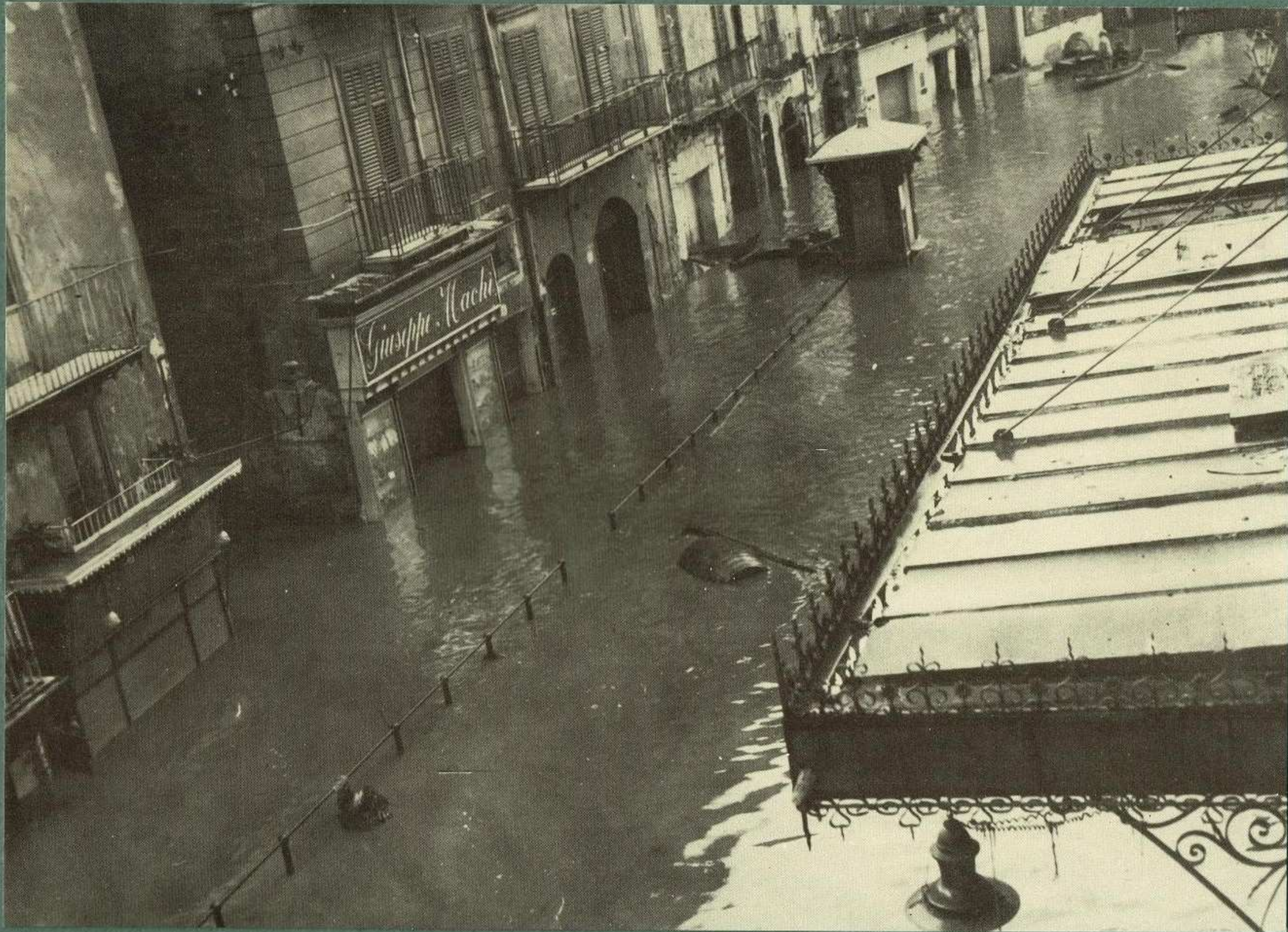
4 - Allagamento della Via Venezia, lateralmente al Teatro Biondo.
