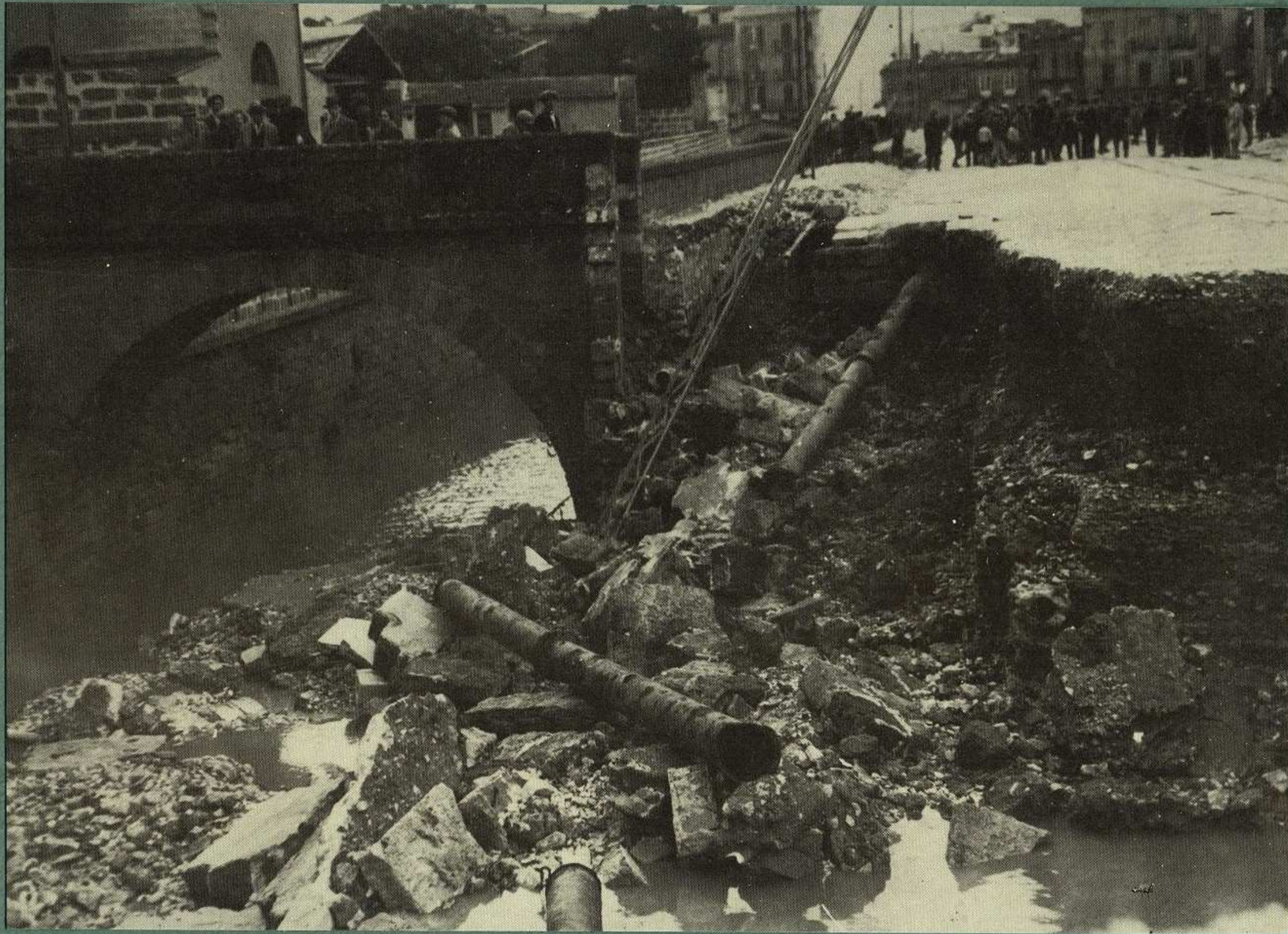
12 - Veduta ravvicinata del trincerone di cui alla foto precedente. La sede stradale, in prossimità di Corso Tuköry, appare interrotta.
