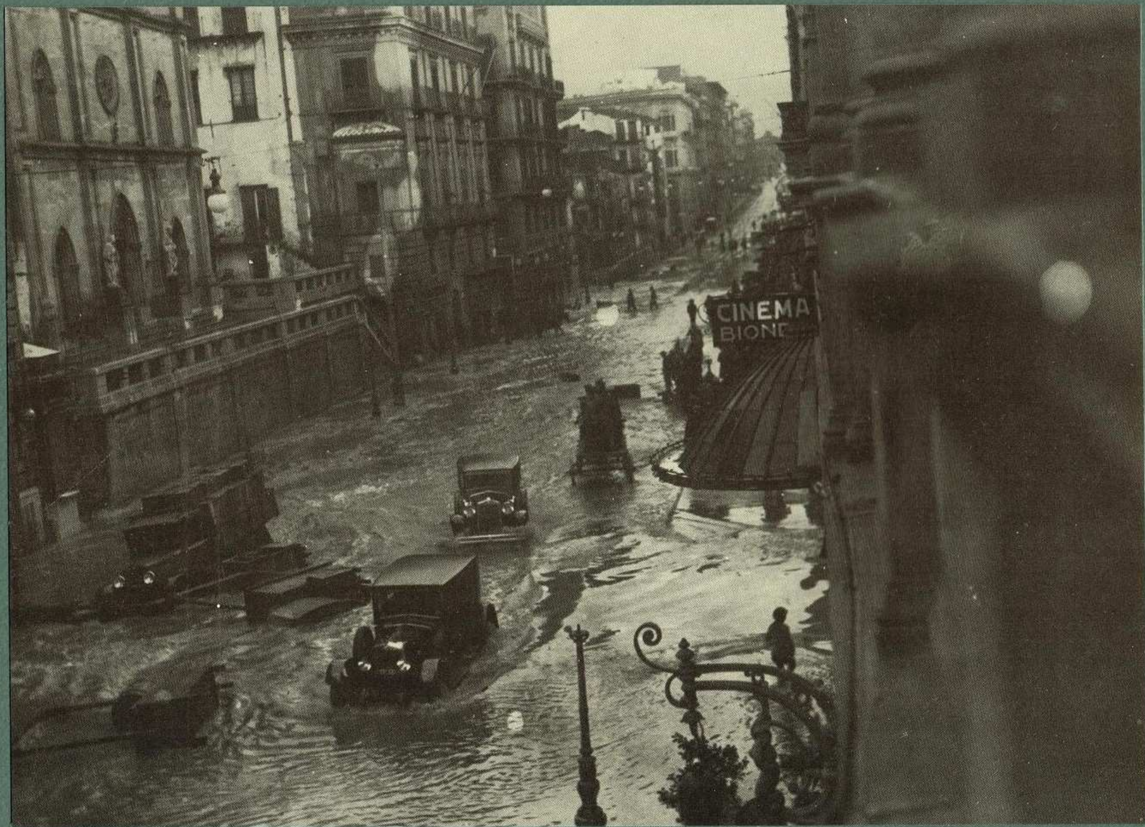
1 - Invasione delle acque, già alte 50 cm, in Via Roma in corrispondenza della parrocchia di S. Antonio.
