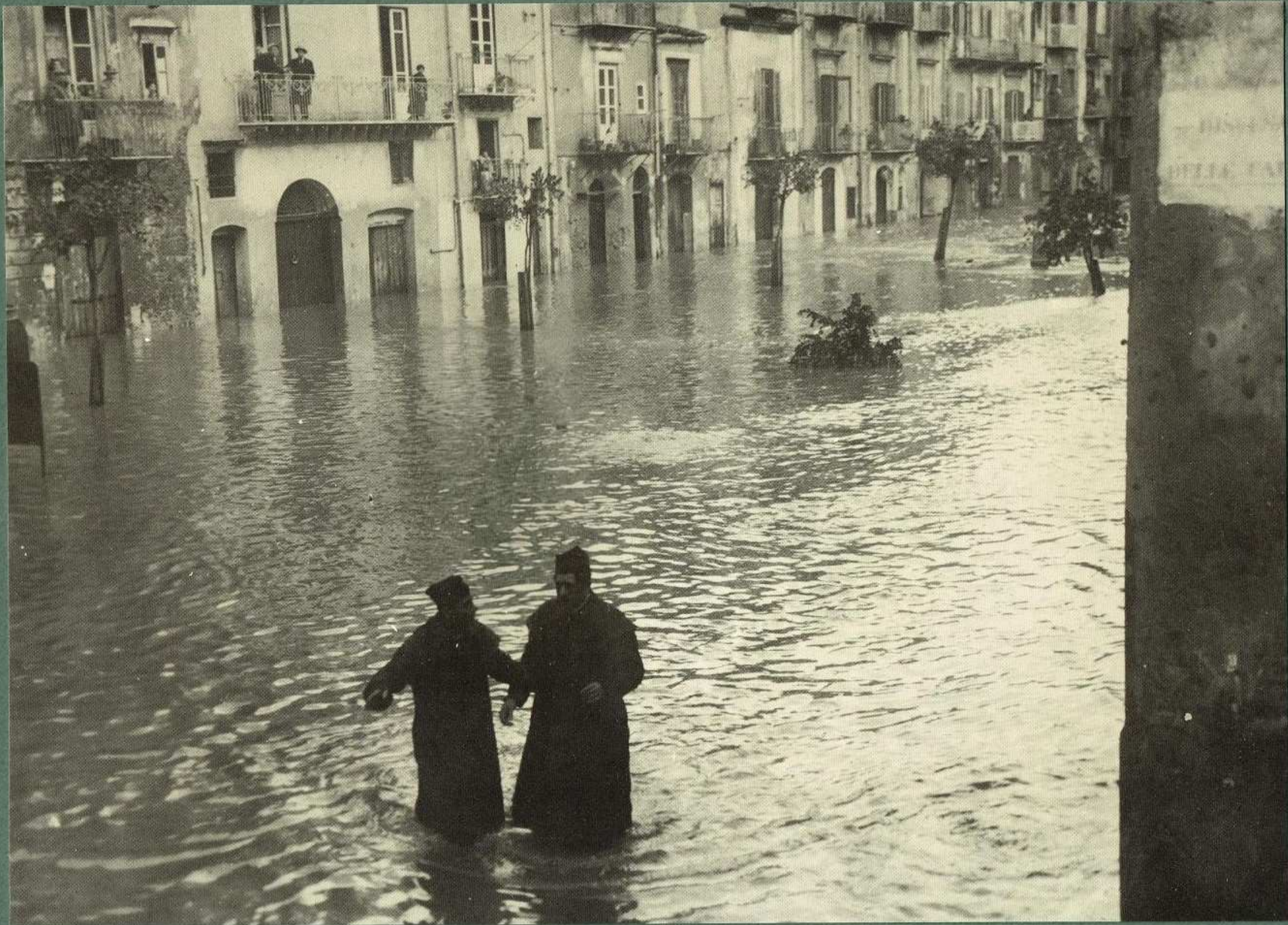
8 - Piazza S. Onofrio. L'acqua è ancora alta 50 cm; successivamente raggiungerà i 6 m.
