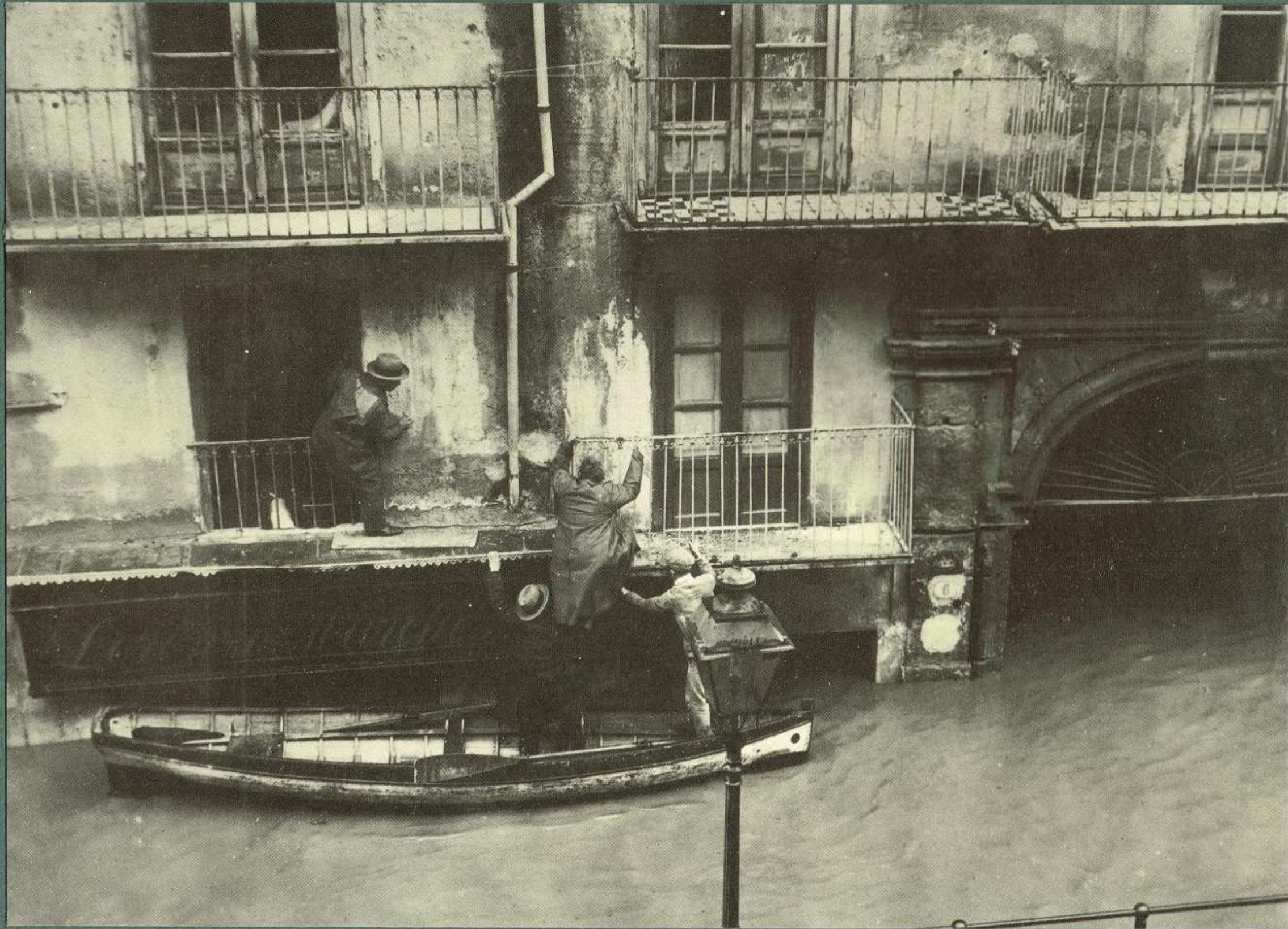
5 - L'emblematica immagine delle acque in Via Venezia che hanno già raggiunto il livello del primo piano.
